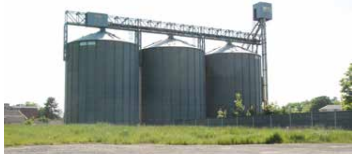
Les anciens silos vont bientôt être démolis.
