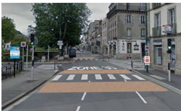
Mise en place d'une signalisation verticale ( panneaux B30 et B51)
