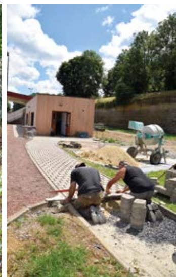
Le pavage du chemin qui mène au Club House du stade Jouanisson, réalisé par les employés d'ADACI.
