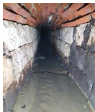
L'eau qui s'écoule part derrière la rue du 8 mai et alimente le "ruisseau de l'ange".
