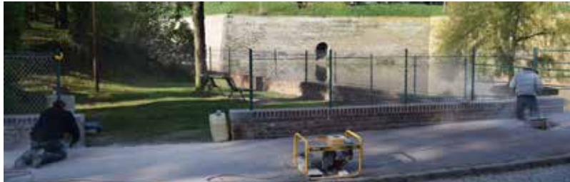
Le Square de l'Union, en travaux.
