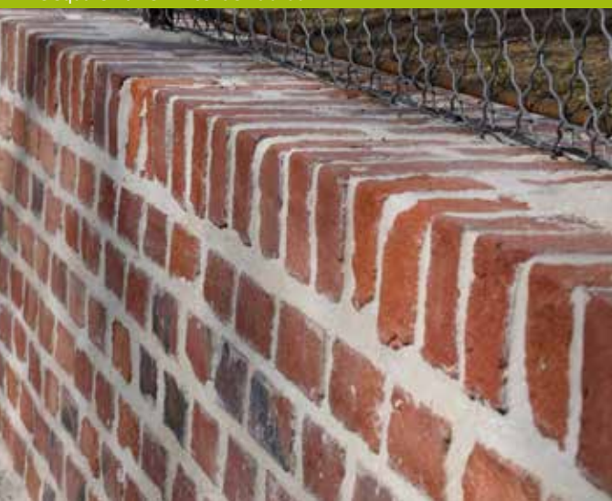
Le Square Daniel Vincent en travaux.
